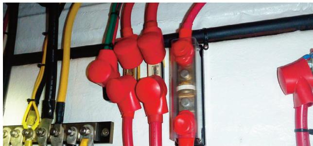
Per il circuito di bonding i cavi elettrici devono avere una sezione minima di 8 mmq
